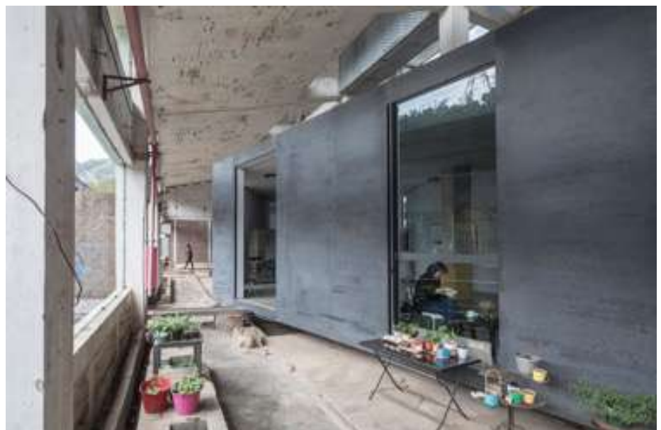
Esta fábrica de telas chinas, una vez abandonada, fue remodelada en un próspero centro cultural por O-Office. Imagen © Laurian Ghinitoiu
