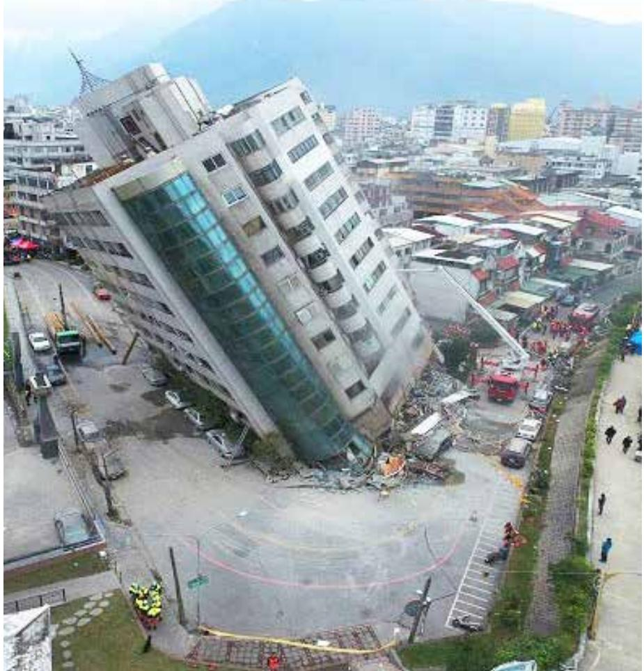
Durante los movimientos se pueden presentar deslizamientos del terreno, agrietamientos del suelo, licuación y asentamientos que son capaces de generar deterioros importantes o, incluso, el colapso total de las estructuras.
