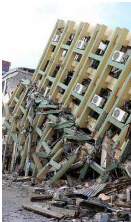
80% de viviendas afectadas eran de construcción mixta y el 20% de hormigón armado; la mayoría de las casas se encontraban sumergidas en un terreno que se convirtió, por el fenómeno de licuefacción, en arenas movedizas.
